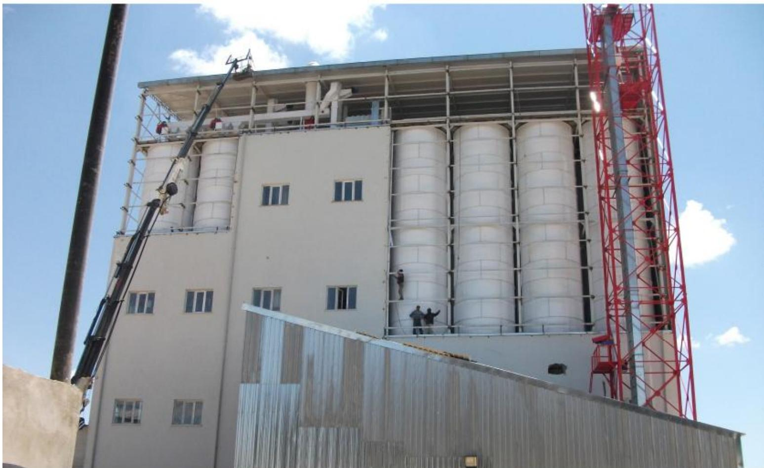
Un, kerepek, irmik, toz ve granül gibi ürünlerin depolanmasında kullanılır. Bütünüyle civatalı birleştirme ile modüller halinde imal edilir. Montaj ve demontajı kolay ve hızlıdır. Modüler sistem müşteri isteğine göre tasarlanır. Talep edilen ölçülerde ve istenilen kapasitelerde dizayn yapılır. Dış kaplama elektrostatik finn boyalı çelik, galvanizli çelik veya paslanmaz çelik olabilir.
